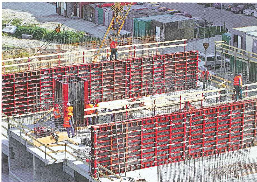
Na stavbe chýbajú aj kontrolóri kvality. Sú to ďalšie náklady na človeka, ktorý navyše dáva veci opraviť, zbúrať, vymeniť, a to sú zase len ďalšie náklady. Technický dozor má však kontrolovať až potom, čo si práce skontroluje stavebná firma.
